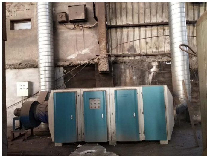
图 4.1-3 该项目浇铸工序光氧催化设备
